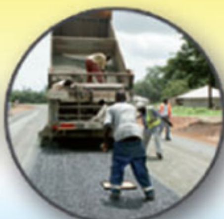
Aménagement de chaussées
